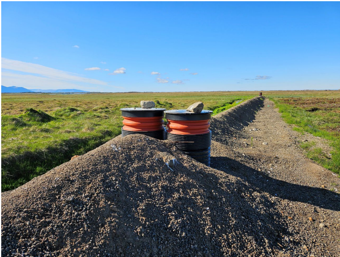
Mynd 7. Dælubrunnar skammt neðan við núverandi hreinsikerfi í Fíflholtum. Frá þessum brunnum verður sigvatni dælt eftir lögn suður í manngerða skurði þar sem frekari hreinsun fer fram.
