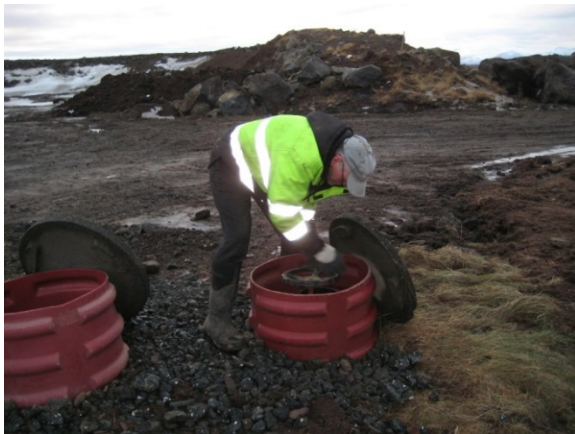
Mynd 5: Yfirfallsloki (stoppkrani). Þessi krani verður alla jafna lokaður, en sé hann opinn streymir sigvatn frá reinum 1 – 3 beint út í settjörn. (Ljós. S.G. 22. jan. 2014).
