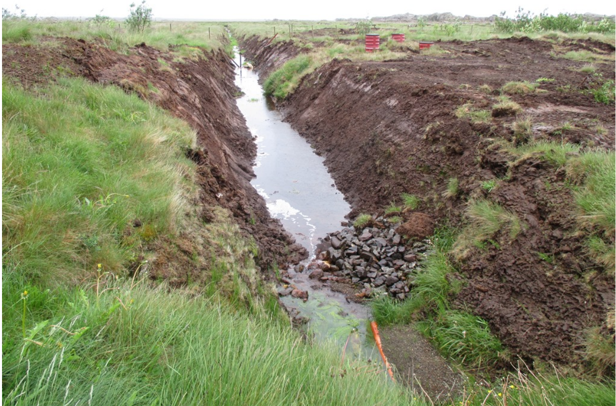
Mynd 4: Horft til suðurs eftir útrásarskurðinum neðan við sandsíuna í Fíflholtum 24. júní 2014. Nýbúið að hreinsa lausan jarðveg og plastruð upp úr skurðbotninum. Grænþörungablóminn til hliðar (vinstra megin) við útrásarrörið sést vel á myndinni. (Ljósm. Stefán Gíslason, (S.G.)).
