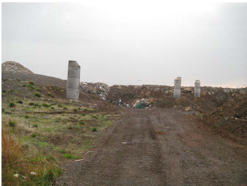
Mynd 8. Horft til norðurs í átt að núverandi suðurenda urðunarreinar nr. 3 í Fíflholtum. Sjá má endann á úrgangstaflanum niðri í reininni, en haugurinn uppi á bakkanum til vinstri geymir timburkurl sem notað er sem yfirlag. Búið er að hækka lagnabrunna vegna lengingar urðunarreinarinnar til suðurs. Brunnurinn lengst til vinstri stendur við enda urðunarreinar nr. 2, en brunnurinn í miðið hefur síðustu árin verið aðalsýnatökubrunnur vegna efnagreininga á frárennslisvatni ofan hreinsivirkis. (Ljósm. S.G. 7. sept. 2010).
