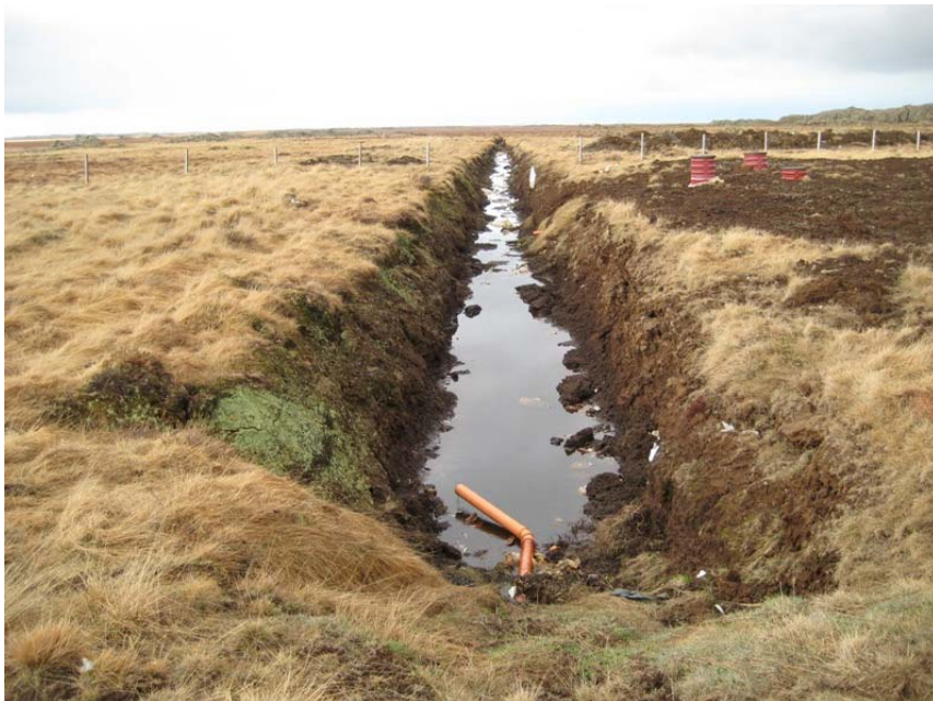
Mynd 6. Frárennslisskurðurinn í Fíflholtum að morgni 8. maí 2008. Eins og sjá má hefur útrásarrör frá hreinsivirki fyrir almennan úrgang verið framlengt til að unnt sé að mæla rennslið. (Ljós. S.G. 8. maí 2008 kl. 9.29).
