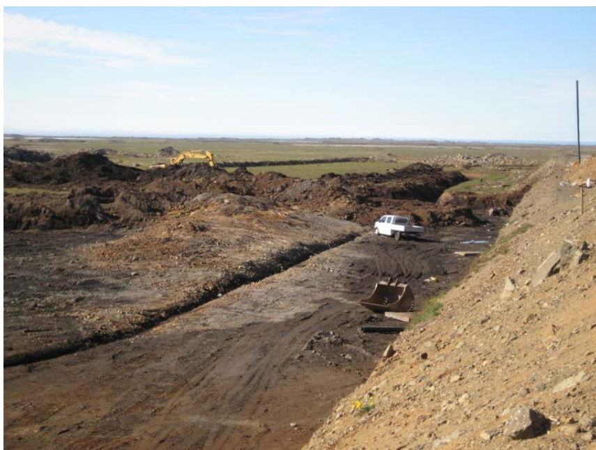
Mynd 1. Framkvæmdir við nýja urðunarrein, urðunarrein 4, í Fíflholtum. Myndin er tekin til suðurs. Yst til hægri sést bakki urðunarreinar 3. (Ljós. S.G. 7. júlí 2008 kl. 9.11).
