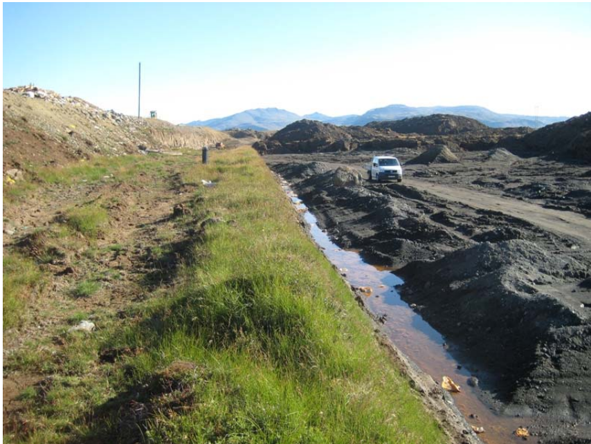
Mynd 7. Frá urðunarstaðnum í Fíflholtum. Myndin er tekin til norðurs austarlega á svæðinu. Eystri brún urðunarreinar 3 er til vinstri á myndinni. Grunnvatnsbrunnur 6 er framundan, og til hægri sést í botn nýrrar urðunarreinar sem unnið er við. (Ljósm. S.G. 12. ágúst 2008 kl. 9.17).
